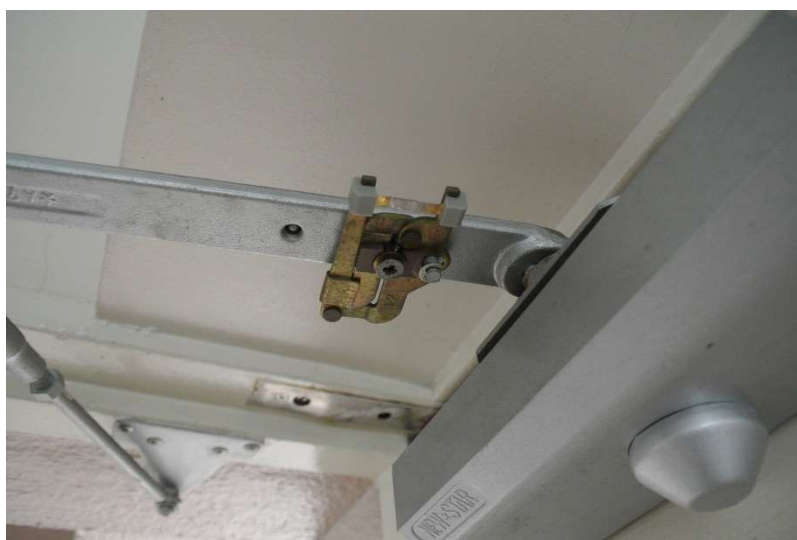
3階B階段側 ヒューズ交換後
