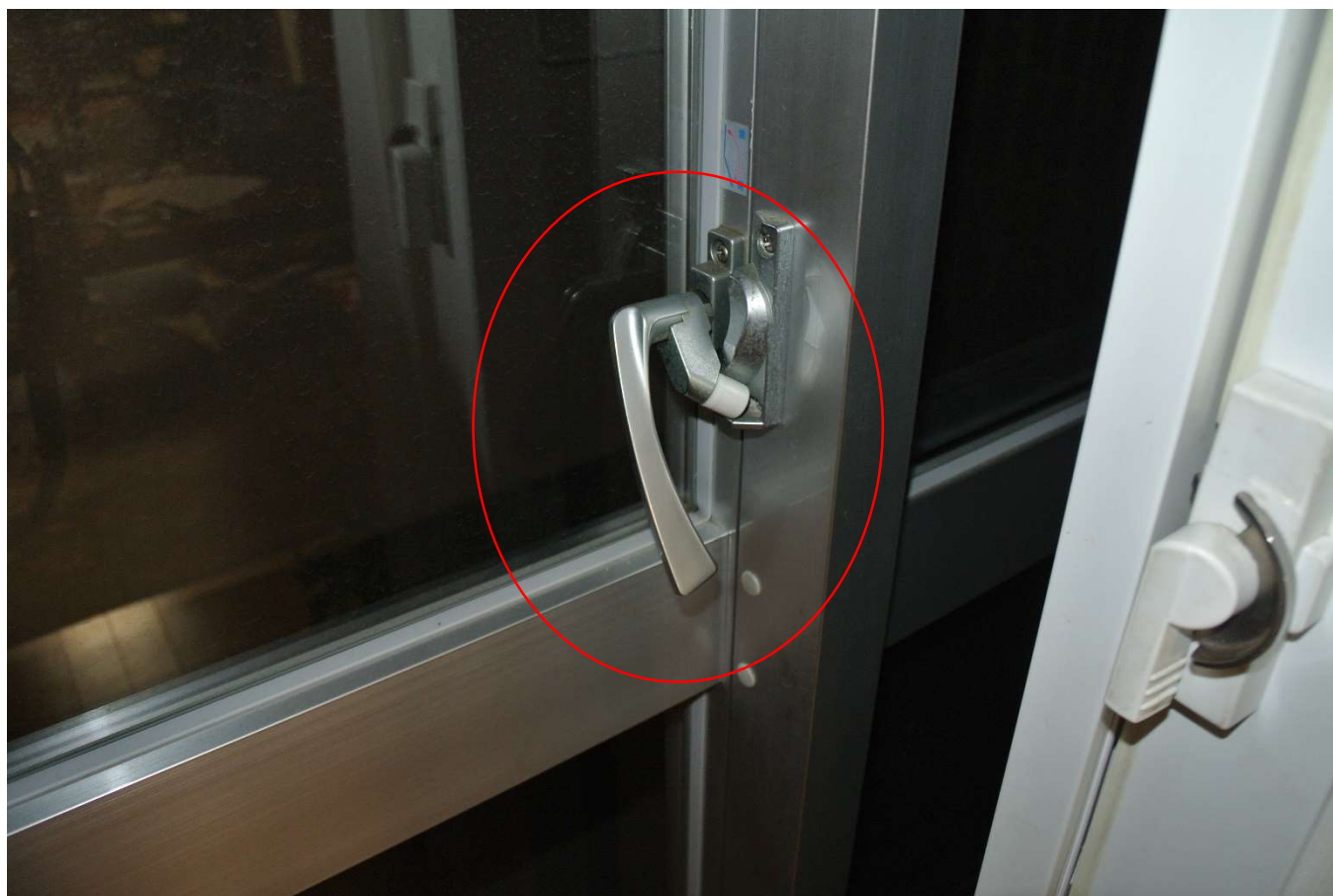
交換したハンドルの場所（写真は201号室）
