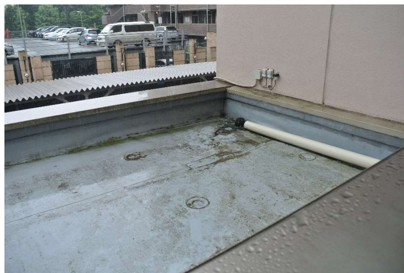
処置後 雨水が排水され溜まらなくなった
